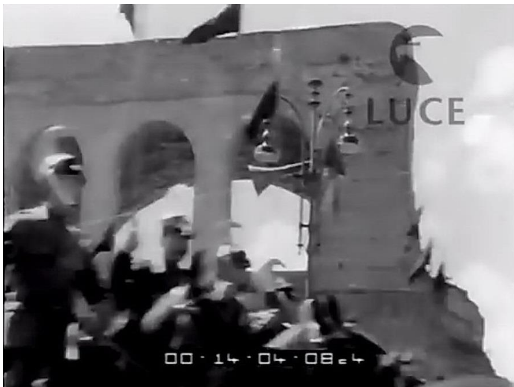
Un altoparlante issato su di un lampioni posto in prossimità della Basilica di Massenzio. La zona è attualmente interessata dai lavori per la costruzione della Metro C.
